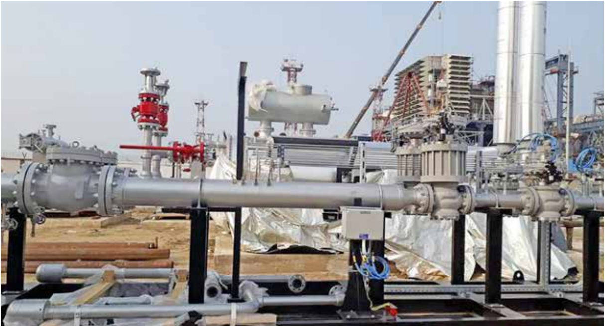
শ্রীহট অর্থনৈতিক অঞ্চল, শেরপুর, মৌলভীবাজার-এ গ্যাস সরবরাহের লক্ষ্যে স্থাপিত রেগুলেটিং ও মিটারিং স্টেশন।
